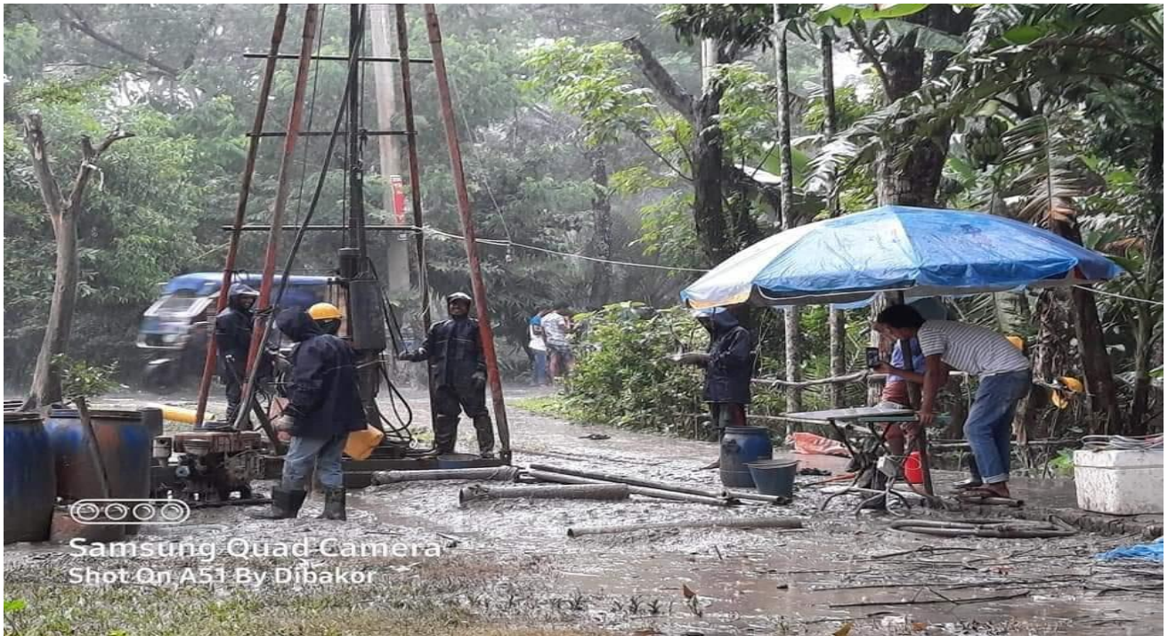
চিত্র-৪৬: কচুয়া-বেতাগী-পটুয়াখালী-লোহালিয়া-কালাইয়া সড়কে পায়রা নদীর উপর সেতু নির্মাণ প্রকল্পের মাটি পরীক্ষা কার্যক্রম
