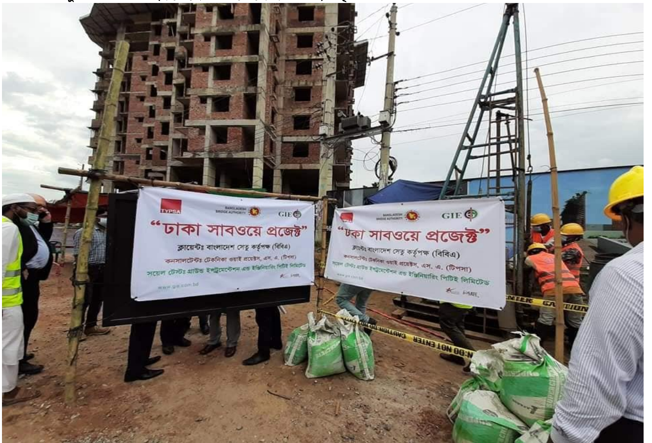
চিত্র-৪২: ঢাকা সাবওয়ে সমীক্ষা প্রকল্পের মাটি পরীক্ষা কার্যক্রম
