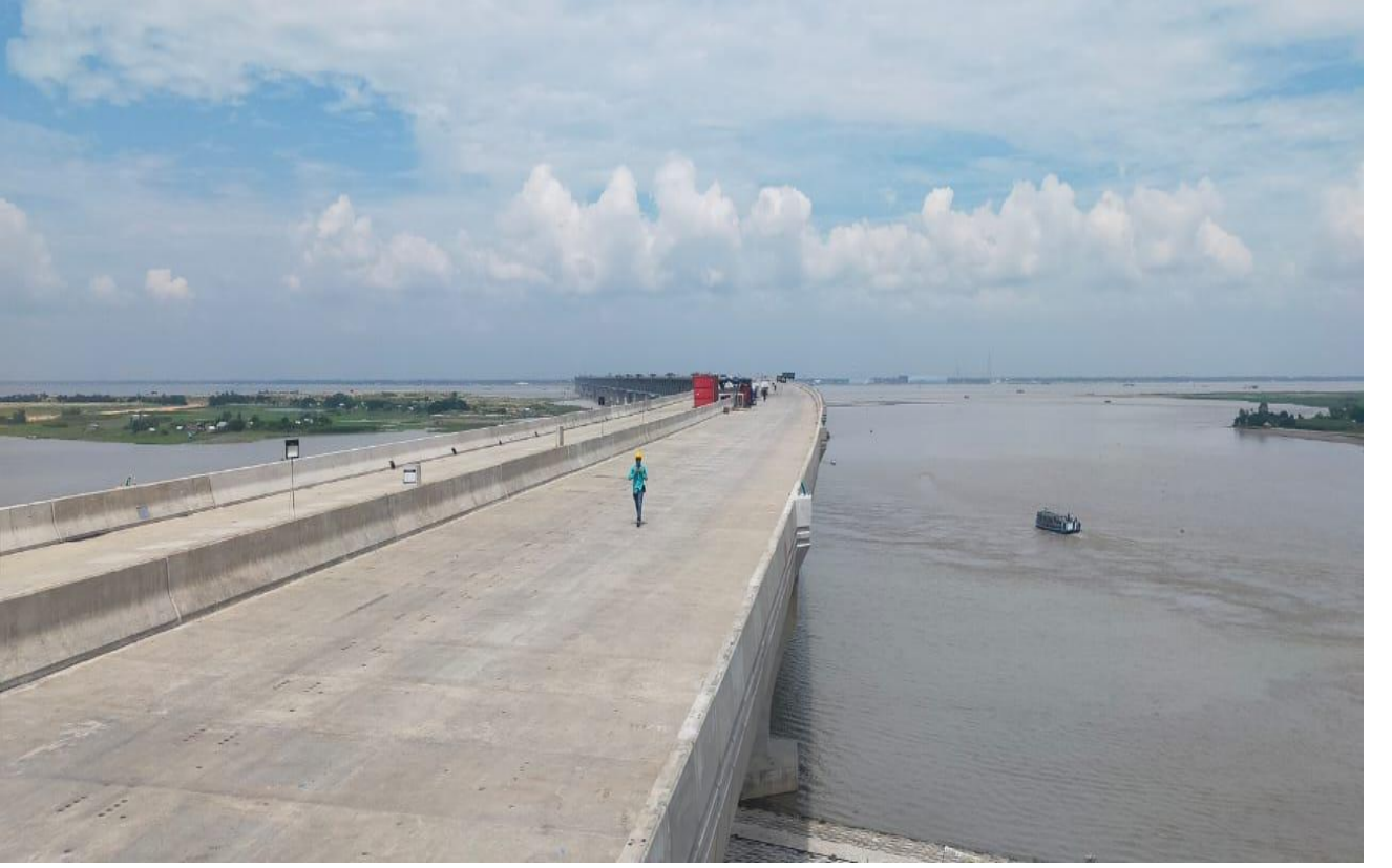
চিত্র-২৭: নির্মাণাধীন পদ্মা বহুমুখী সেতুর জাজিরা-মাওয়া রোডওয়ে
