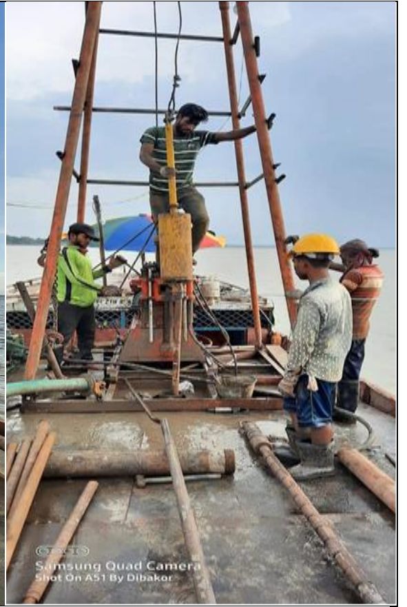
চিত্র-৪৫: কচুয়া-বেতাগী-পটুয়াখালী-লোহালিয়া-কালাইয়া সড়কে পায়রা নদীর উপর সেতু নির্মাণ প্রকল্পের মাটি পরীক্ষা কার্যক্রম
